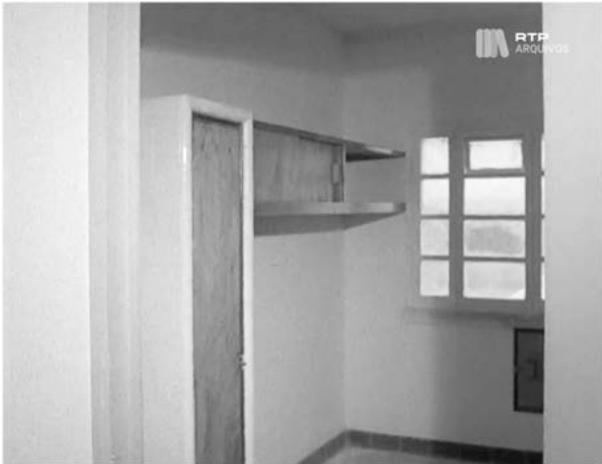
fig. 6 - Vista do interior de uma cela na penitenciária (em construção, 1968)
