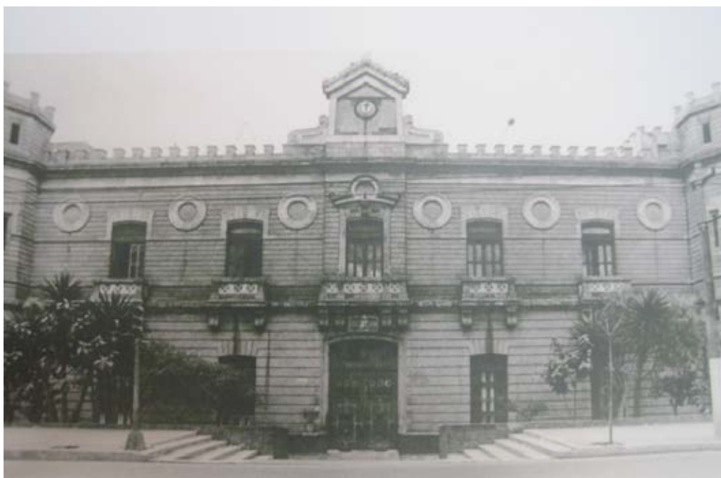
Ilustración 8.- Fachada principal de la penitenciaría. Fuente: (Sánchez L. I., 2012)
