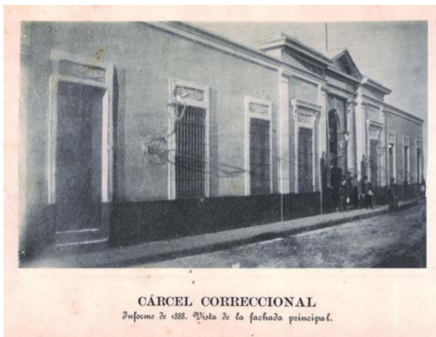
Fig. 3 Frente de la Cárcel Correccional en 1888, calle San Juan 77 15
