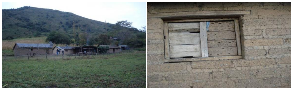
Figura 6: Viviendas de adobe
